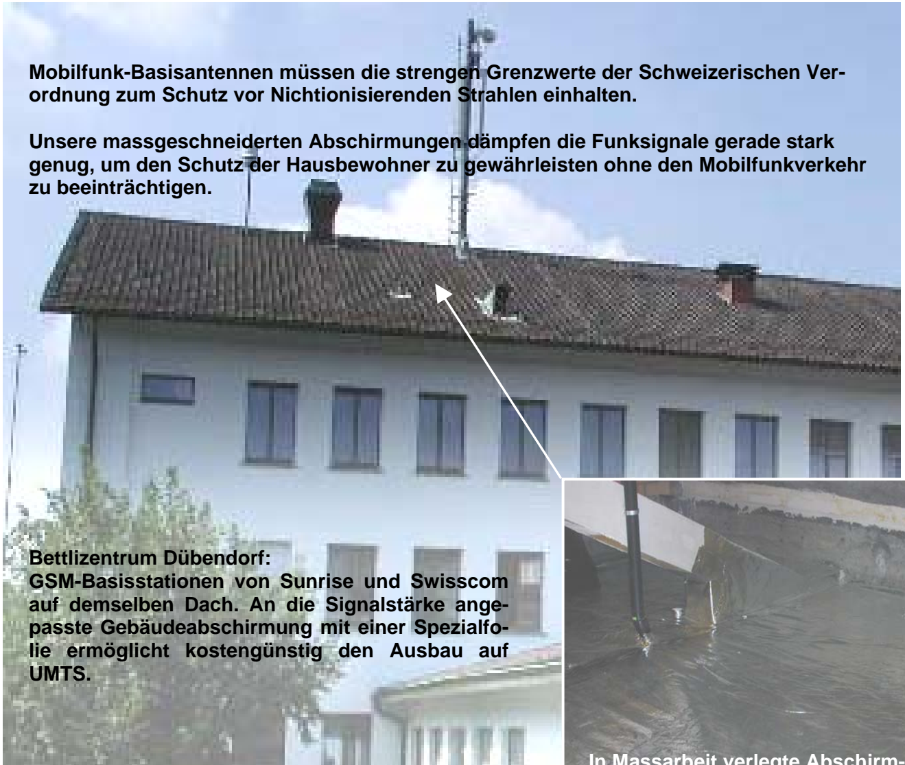
In Massarbeit verlegte Abschirm-Folie im Dachstock
